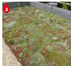
TOITURE VÉGÉTALISÉE « SHOW ROOM OFFICE INTERNATIONAL DE SEULI » Source : ATM
