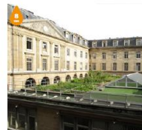
TOIT POTAGER RUE LOUÏS PARS 20 Source : © PARCULTURS / Mairie de Paris
