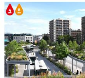
TOITURE VÉGÉTALISÉE EXTENSIVE À HOTEL MALMAISON (92) Source : © QUATREVENTOURE/ASIN
