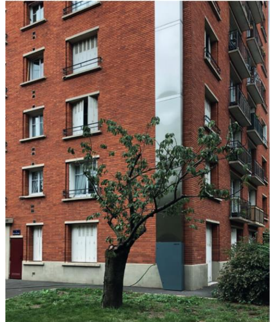
Cuve en INOX de récupération des eaux pluviales sur résidences Paris Habitat (Paris, 10 e )
