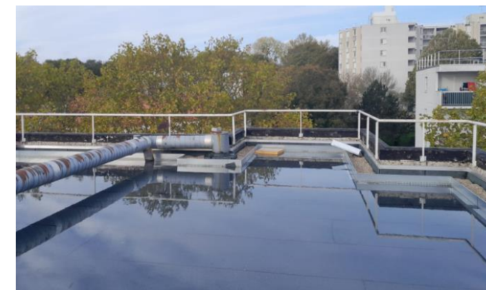
Essai en eau post travaux d'étanchéité – nov 2022
