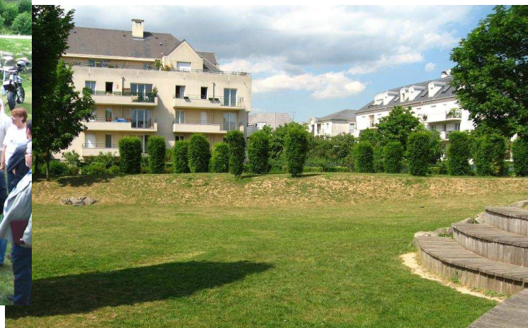
Bassin de rétention des eaux pluviales des bâtiments environnants : utilisation de l'espace et de la topographie
