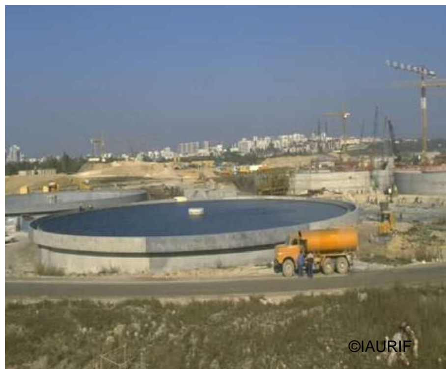
Construction de la station de Valenton, 1985
