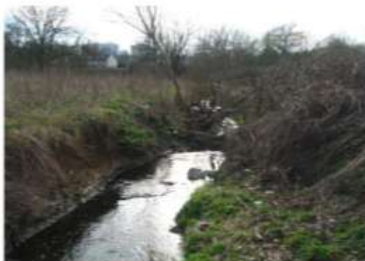
Berge du Morbras non entretenue au niveau de la cuvette d'Amboile, Ormesson-sur-Marne
