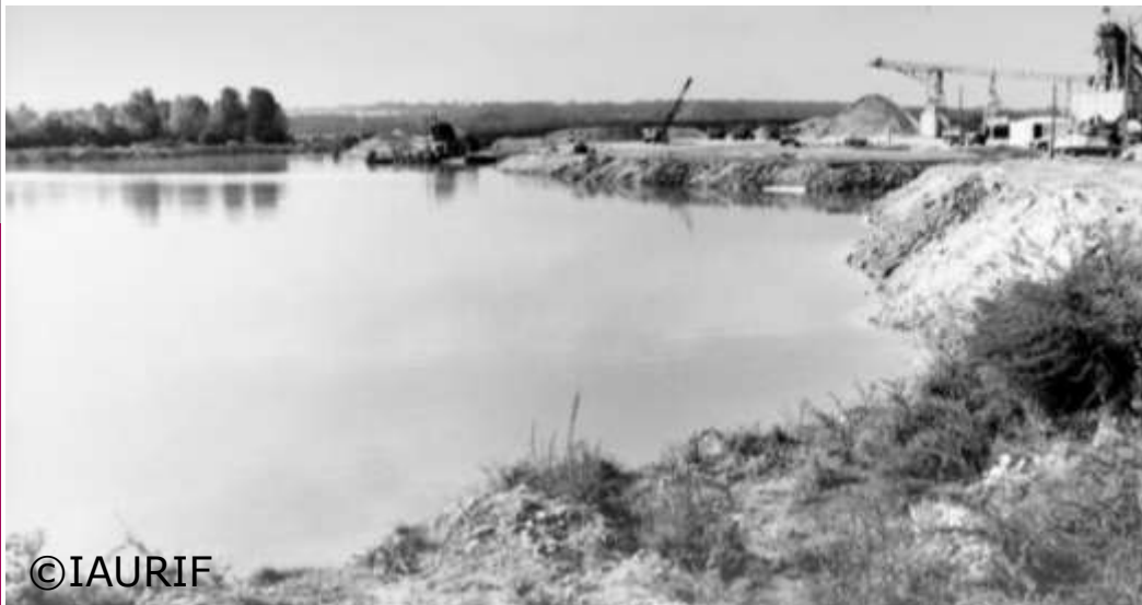
Construction de la base de loisirs de Vaires, années 1970
