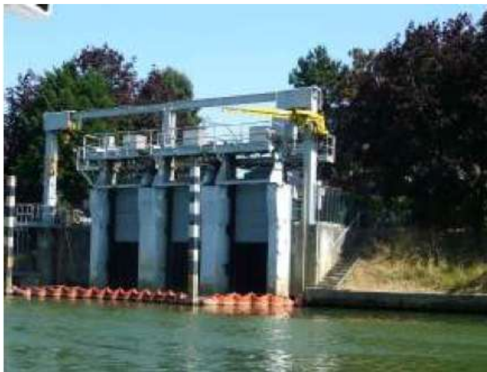
Prise d'eau pour l'usine d'eau potable de Neuilly-sur-Marne
